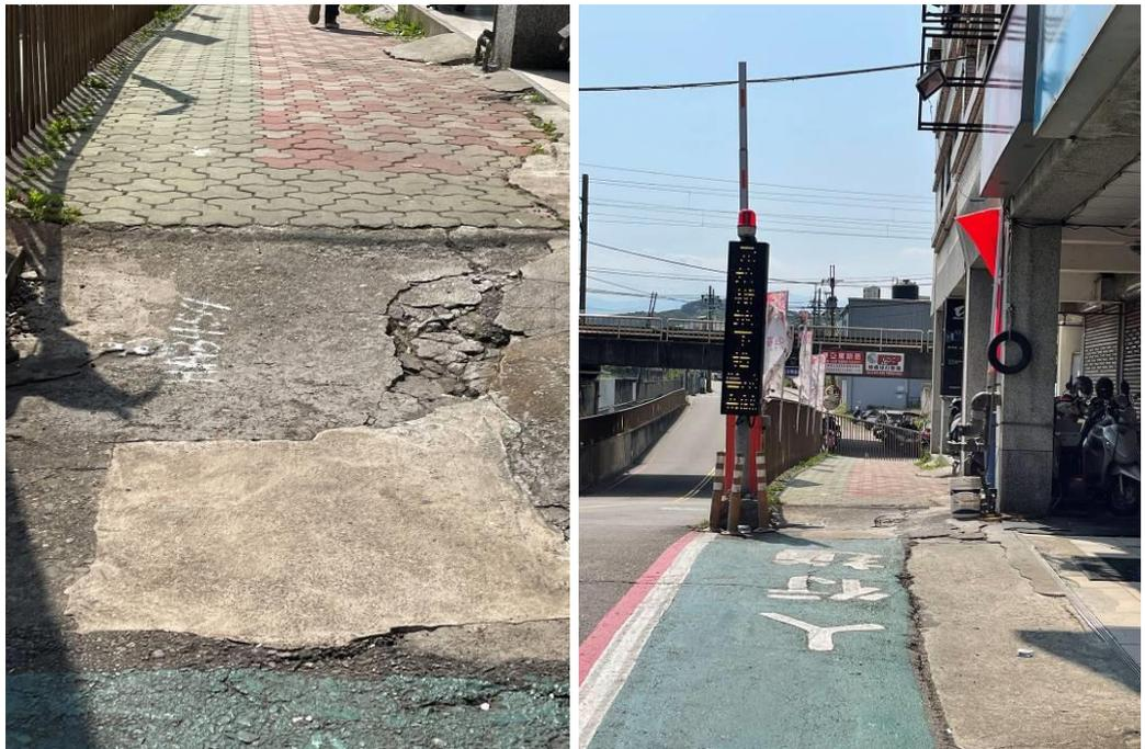
**決 議：**據委員表示該處路段常有積水問題，且人行道鋪面與相鄰路面有高低差，若僅片段補強，經車輛行駛後容易又會發生路面龜裂破損狀況，造成輪椅行經危險，本案請工務處督導廠商就該路段整體改善。
